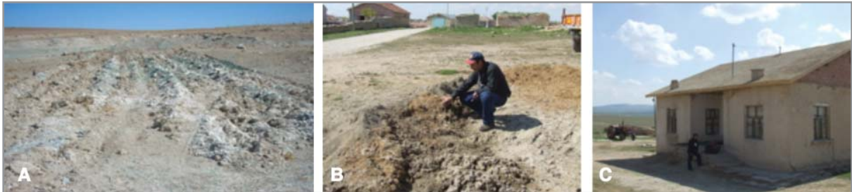
Resim 5. (A) Yenice (Maydos) Mahallesi yakınında tremolit asbestli alan tarla gibi sürülerek yüzeye çıkartılan malzeme, (B,C) Asbest malzeme çamurtaşı ve kireçli toprakla karıştırılarak harç yapılmakta ve bu harç evlerin damlarında izolasyon maddesi ve sıvada kullanılmaktadır (1,16,17).
